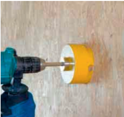
Perçage d'une ouverture circulaire
