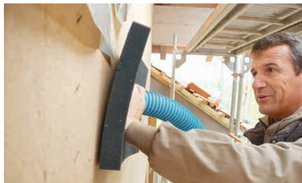
Insufflation avec tuyau et carré de mousse
