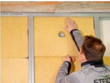
STEICOflex 036 für die Dämmung von Vorsatzschalen und Installationsebenen
