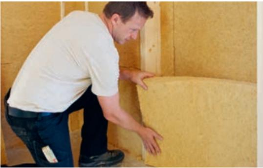
STEICOflex 036 für die flexible Gefachdämmung in Dach-, Wand- und Deckenkonstruktionen
