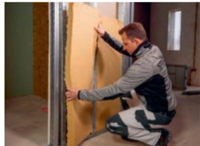
STEICOflex 038 für die Hohlraumdämmung bei Trennwänden
