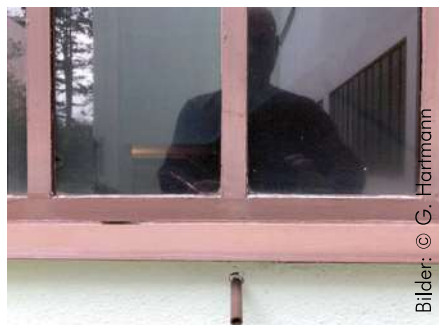
1, 2 | Typisches 1920er-Jahre-Fenster: Auf seiner kühlen Oberfläche schlägt sich viel Tauwasser nieder, tropft auf den Sims in eine Muldenrinne und fließt durch ein dünnes Röhrchen nach außen ab.
