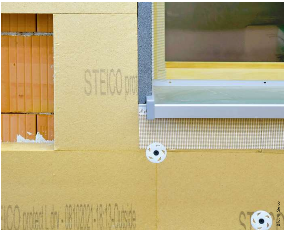
7 | Sichere Lösung: Die Fensterlaibung ist mit der 4 cm starken Holzfaser-Laibungsplatte SteicoProtect gedämmt, über dem Simsblech mit der systemintegrierten Spritzschutzplatte SteicoSecure SGB.
