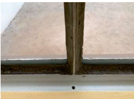
1, 2 | Typisches 1920er-Jahre-Fenster: Auf seiner kühlen Oberfläche schlägt sich viel Tauwasser nieder, tropft auf den Sims in eine Muldenrinne und fließt durch ein dünnes Röhrchen nach außen ab.
