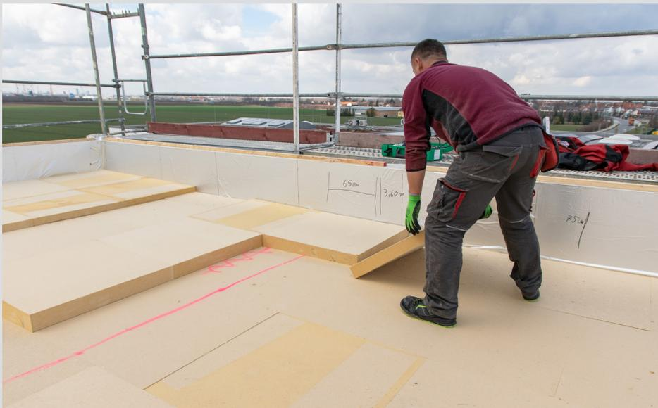
Die Dämmplatten werden nicht geklebt, sondern verlegt und am Ende mechanisch befestigt.
