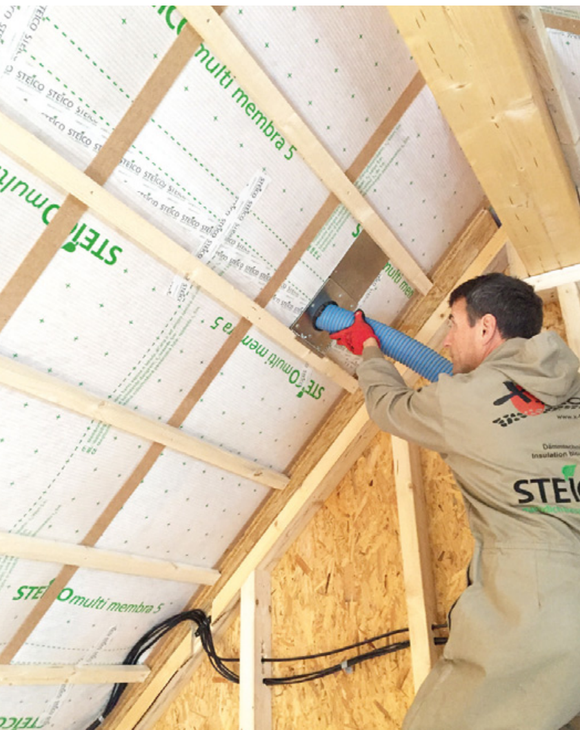
Einblasdämmstoffe sind manchmal eine sinnvolle Alternative, dürfen allerdings nur von dafür zertifizierten Handwerkern eingebracht werden.
