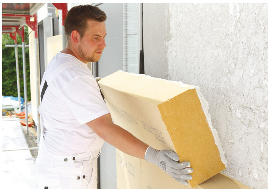
Die STEICOprotect 037 wird mit einem mineralischen Klebe- und Armierungsmörtel auf die Außenwand geklebt.
