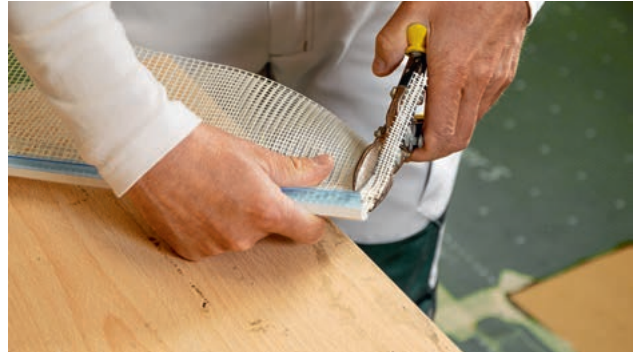
9 Zuschnitt von STEICO secure Mesh 4*4, Gewebeeckwinkel, Abschlussprofil FB
