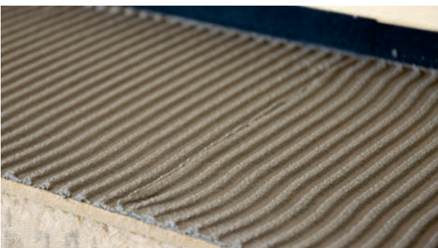
8 Das Abzählen in Gefällerrichtung erfolgt mit einer 6,0mm Zahntraufel, um eine Trockenschichtdicke von mind. 4,0 bis max. 10,0mm zu erzielen
