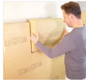
Verlegung kleinformatiger stumpfer Platten
