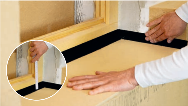
6 Höhennivellierung, restliches Abziehen des Trennpapiers und Andrücken des STEICO multi tape black umlaufend
