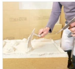
Dämmplatte ankleben auf unebenem Untergrund im Punkt-Wulst-Verfahren
