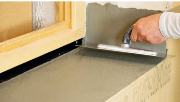
7 Danach Vorziehen des gesamten Keils sowie des unteren Laibungsbereichs mit STEICO secure Base Guard
