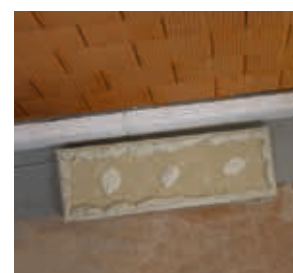
Si le support a des inégalités, utiliser la technique de collage boudin et plot
