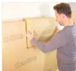
Posa di pannelli di testa di piccolo formato
